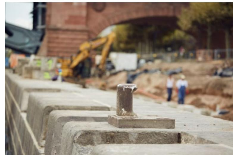
Wie Zahnlücken stechen jene Stellen ins Auge, an denen Blöcke der massiven Kaimauer bei den Arbeiten entfernt wurden.
