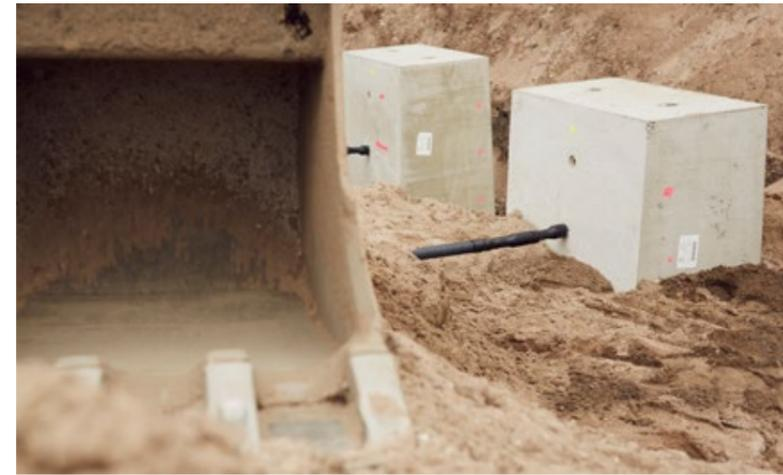
Die Stahlbeton-Anker, welche die Mauer fest mit dem Ufer verbinden, sind mittlerweile unter Erde und Asphalt verborgen.
