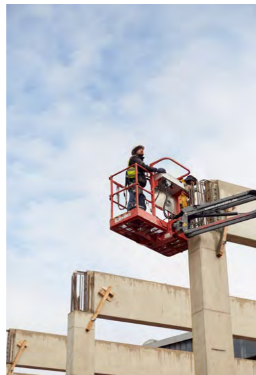
Von Tiefbau bis Hochbau: Bei der Erweiterung der Produktionshalle kamen viele Gewerke zum Einsatz, die für die Einhaltung des Zeitplans effektiv zusammenarbeiteten.
