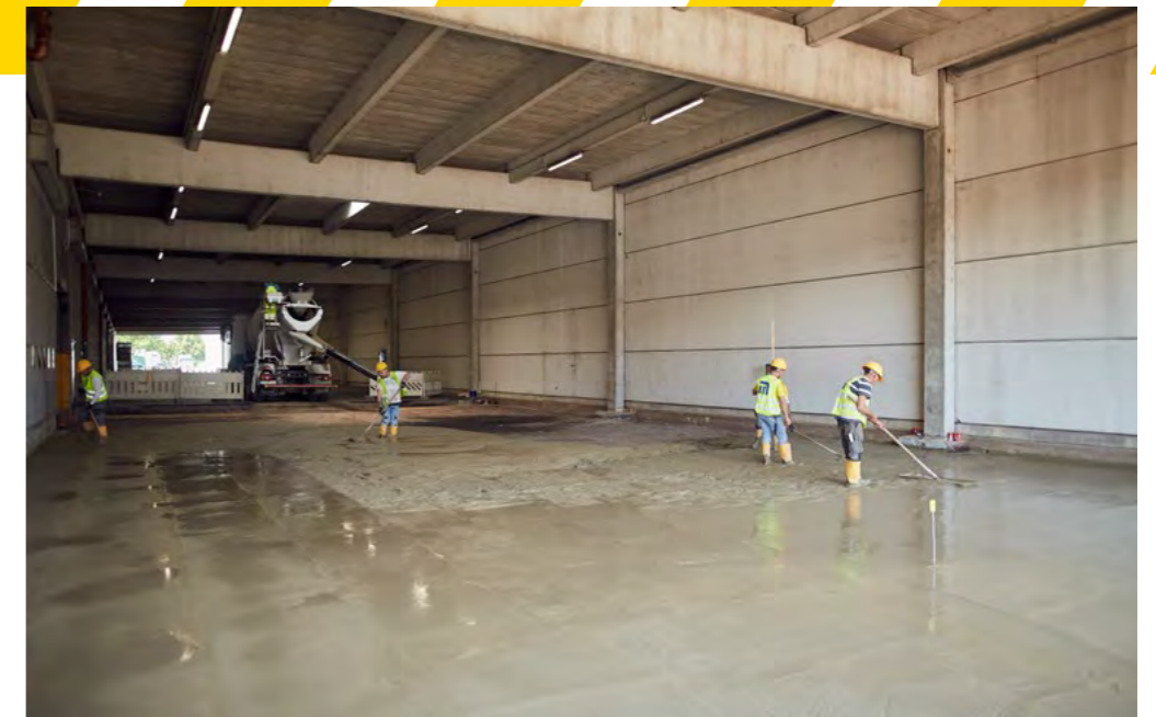
In Windeseile errichteten unsere Mitarbeiter eine provisorische Halle und ein System, um die Paletten mit Gütern sicher umzulagern.
