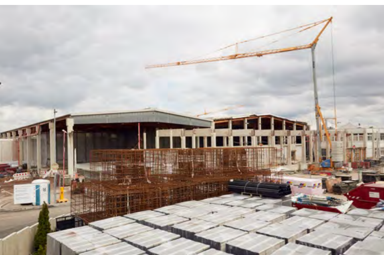
Trotz weltweiter Engpässe rechtzeitig vor Ort: Neben dem geschäftigen Treiben warten die Stahlbeton-Armierungen und weiteres Baumaterial auf ihren Einsatz.
