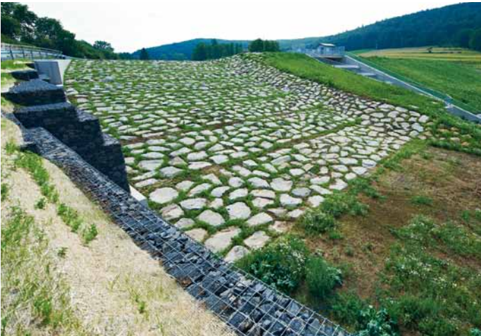
Oben: Durchlasswerk mit Betriebsgebäude. Unten: Dammscharte zur Überlaufentlastung.
