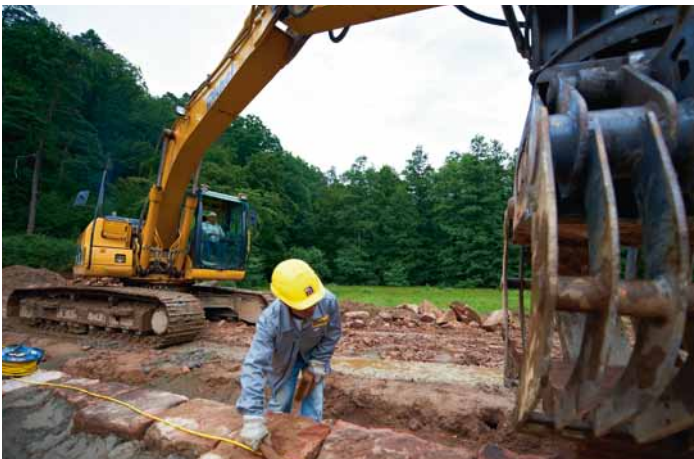
Die Spezialisten von Michel Bau sanieren die Sandsteinmauern des historischen Triftdamms bei Waldaschaff.
