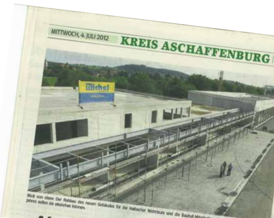
Blick von oben: Der Rohbau des neuen Gebäudes für die Haibacher Wehrleute und die Bauhof-Mitarbeiter steht. Im Frühsommer nächsten Jahres sollen sie einziehen können.
