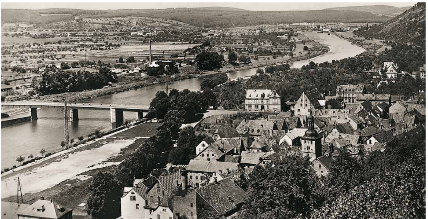
Die Mainbrücke von Klingenberg ist nicht nur für die Stadt ein bedeutendes Bauwerk, auch für das Unternehmen Michel Bau ist die 1880 erstmals errichtete und 1949 wieder eröffnete Brücke ein wichtiger Bestandteil der Unternehmensgeschichte.
