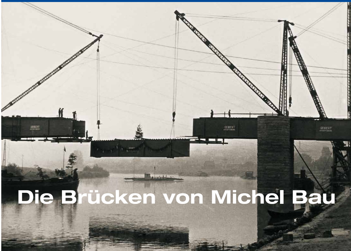
Anfang der 50er-Jahre. Beim Richtfest der Freudenberger Mainbrücke wird das Mittelstück, auf dem der Richtbaum gut zu erkennen ist, von riesigen Kranen eingesetzt. Michel Bau ist an der Realisierung dieses Brückenprojekts maßgeblich beteiligt.
