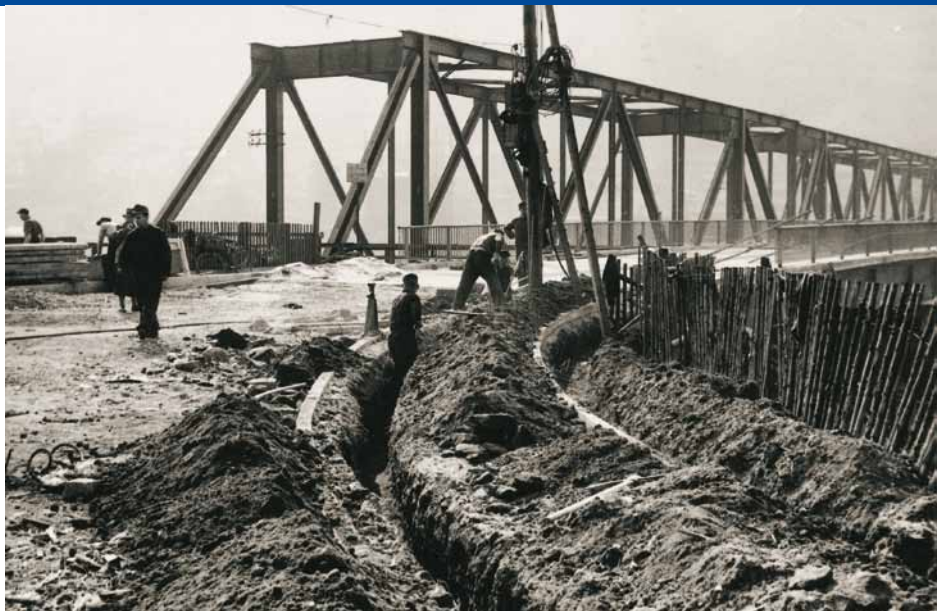
Von 1951–52 sind die Arbeiter von Michel Bau mit dem Wiederaufbau der neuen Mainbrücke Wertheim beschäftigt.
