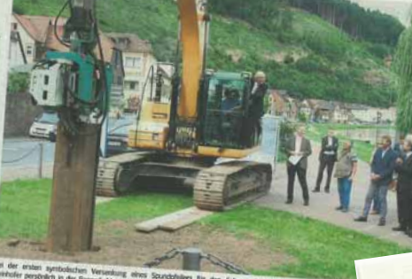
Bei der ersten geotechnischen Versetzung eines Spundpiles für den Schwarzviertel-Hochwasserschutz half die Baufirma (von rechts) auch Miltenberger Bürgermeister Jürgen Bauer und Landrat Helmut Schöng.
