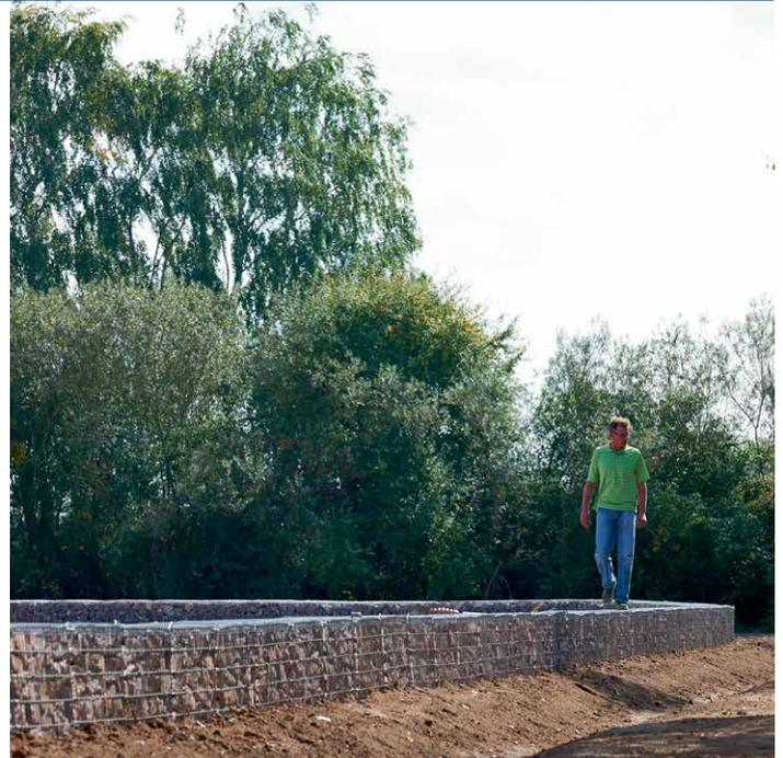
Schweres Gerät und unzählige LKW-Ladungen braucht es, um das 36.000 m<sup>2</sup> große Baugelände abzuräumen. Mit groben Steinen gefüllte Drahtgitterkörbe dienen der Abgrenzung und Strukturierung.
