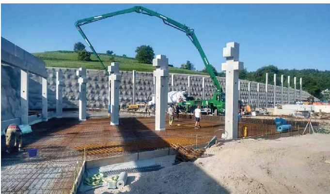
Die Spezialisten von Michel Bau beim Betonieren der Bodenplatte.
