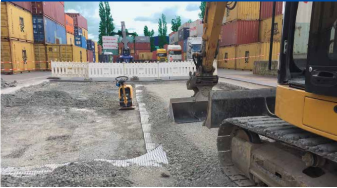
Auf das stabilisierende Geogitter wird die neue Schottertragschicht aufgebracht, anschließend erfolgt die Asphaltierung.
