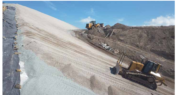
Bei der Sanierung setzte Michel Bau schweres Gerät ein.
