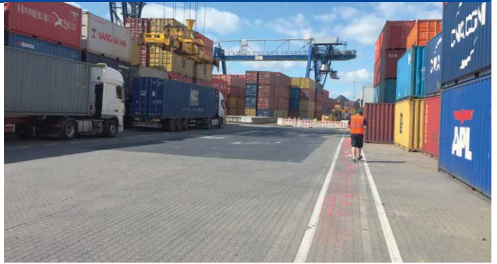
Die von der Sanierung betroffenen Verkehrsflächen im Containerhafen Frankfurt-Ost mussten nur kurzfristig gesperrt werden. Der Containerumschlag konnte fast ungehindert weiterlaufen.
