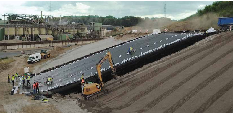
Aufbringen von Filtervlies, Geokunststoffen und Schutzvlies.
