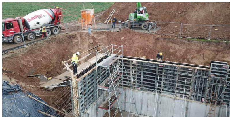
Michel Bau bei der Herstellung des offenen Stahlbetonbeckens.
