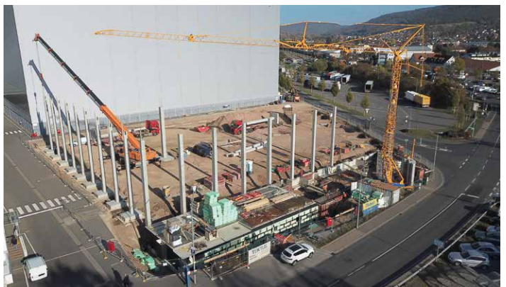
Die vertikalen Stützen für die Produktionshalle sind teils mit den Köcherfundamenten am Verwaltungsgebäude verbunden.
