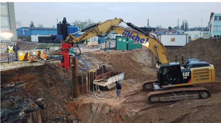
Verbundarbeiten mit der MOVAX-Hochfrequenzramme.
