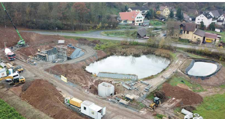
Links entsteht das neue Regenklärbecken, rechts befindet sich der Ersatzteich bzw. das Laichgewässer.
