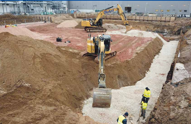
Nach der Bodensanierung wird das Areal wiederhergestellt und mit konditioniertem Bodenaushub aufgefüllt.
