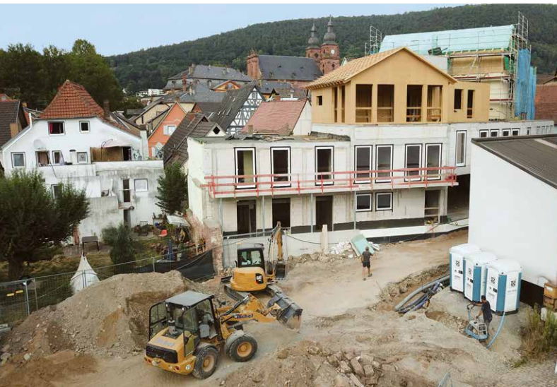
Erweiterungsbau/Anbau des neuen Stadthotels, ausgeführt von Michel Bau.
