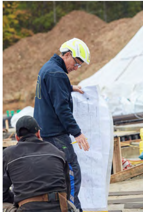
Bloß den Überblick behalten. Beim Verlegen des Rohrsystems ging Polier Burkhard Schreck mit großem Plan vor.
