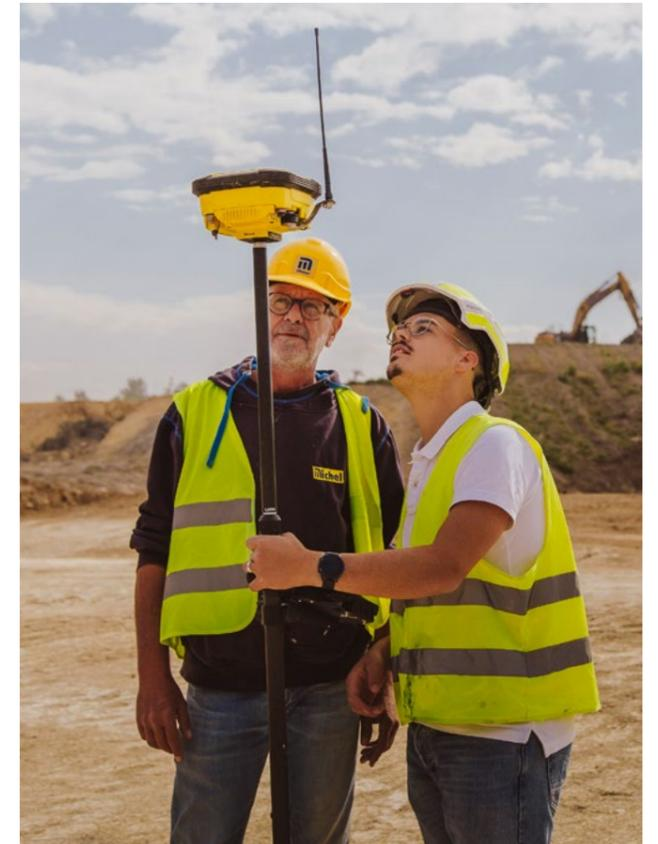
Die Bauleitung überprüft mit einem GPS-Gerät sorgfältig das Niveau der abgetragenen Fläche.
