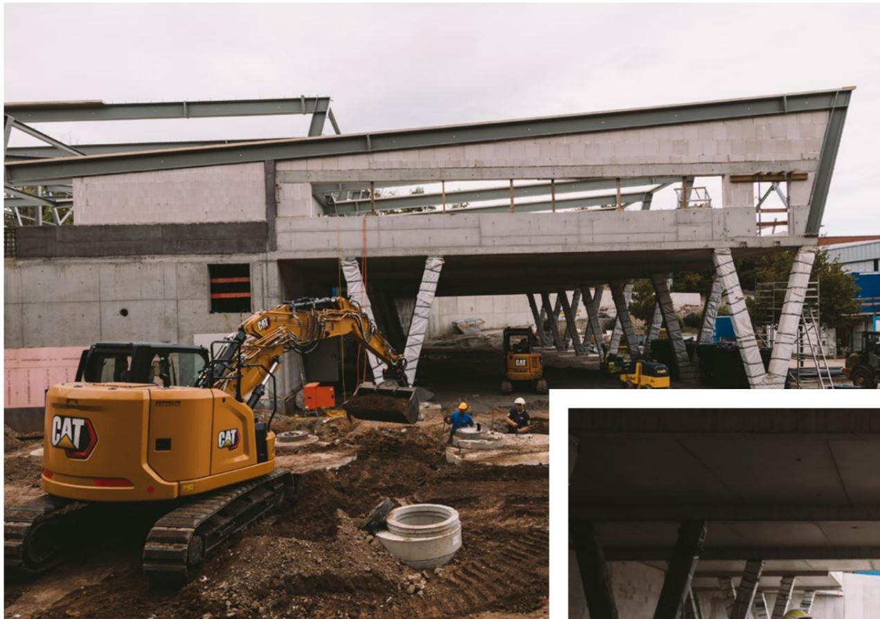
Alles stabil? Das fertig betonierte Parkdeck liegt sicher auf den angelieferten V-Stützen. Das Team ist zufrieden.
