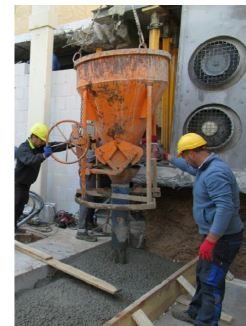
Während drinnen die Produktion reibungslos weiterlief, wurden außen die Fundamente für die neuen Wände gegossen.
