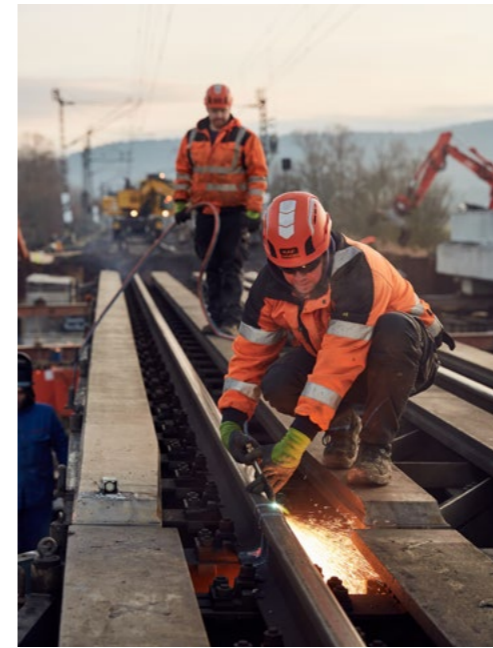
Die Firma Falkenhahn übernahm alle Arbeiten rund um den Gleisbau, wir von Michel Bau stemmten eine Menge Logistik und die umfangreichen Spezialtiefbau-Aufgaben.
