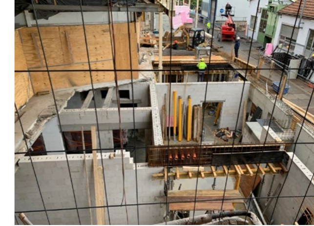
Stahlträger wurden eingezogen und die Wände gemauert. Der Blick in die neuen Kellerräume.
