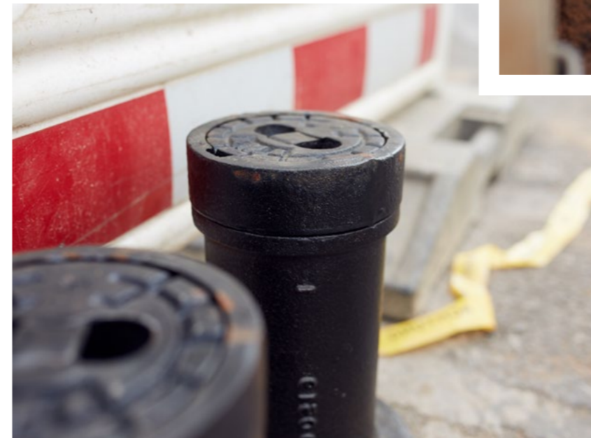
Ort: Klingenberg Zeitraum: April 2018 - April 2021 Bauleiter: Peter Sendelbach Polier: Matthias Vogel
