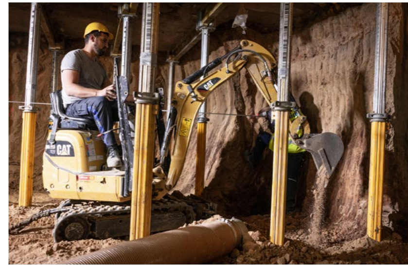
Mit dem Saugbagger wurde die Erde mit Unterdruck aus dem Keller gesaugt und über einen flexiblen Schlauch direkt auf einen Lkw gepumpt.
