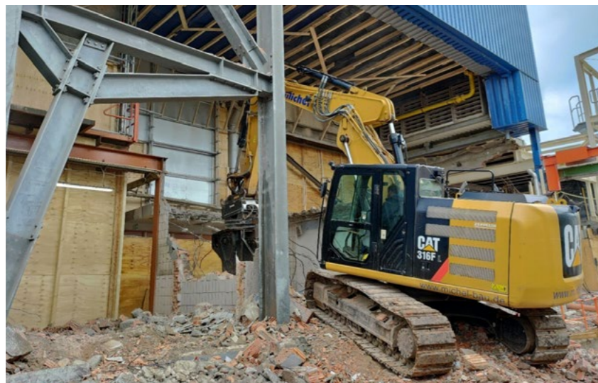
Die Holzverschalung schützt die Produktionshallen vor Staub, während der Bagger unermüdlich weitergräbt.
