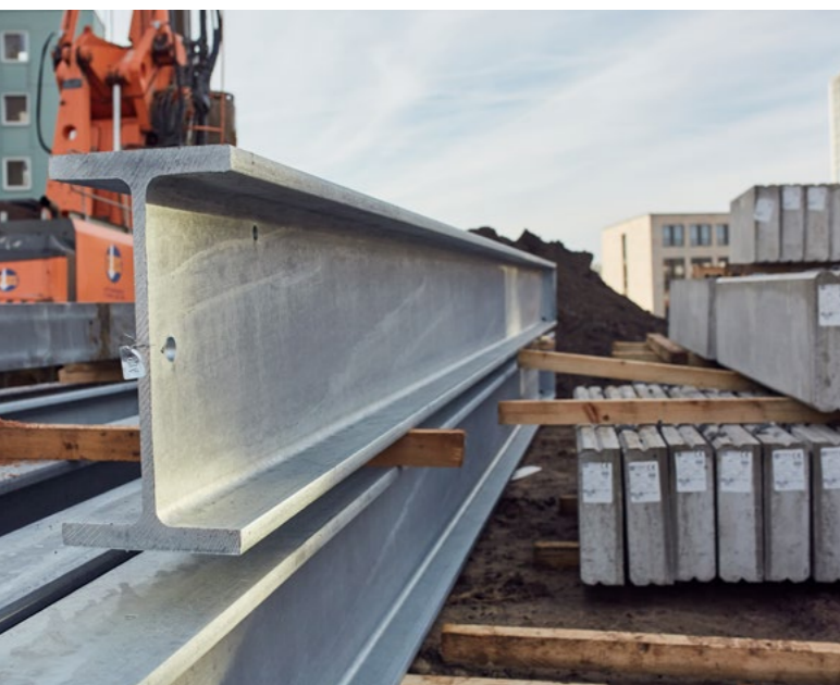
Der Stahlbau musste präzise an den Verbau angepasst werden. Es wurden spezielle Stahl-Fertigteile auf Maß hergestellt und verbaut.
