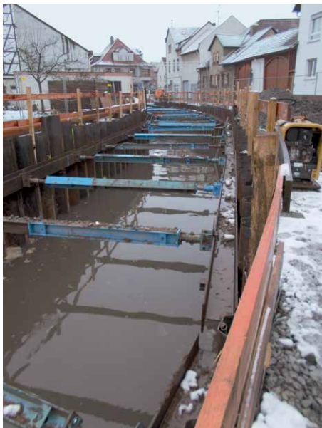
Sieht aus wie die Einfahrt zu einem Tunnel, zeigt aber in Wirklichkeit die Sanierung eines Kanals. Nach Beendigung der Arbeiten hat Michel Bau die Oberfläche wieder hergestellt, sodass der Welzbach weiterhin unterirdisch verläuft.
