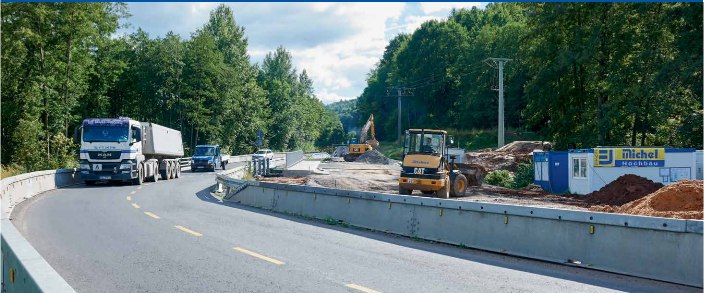
Michel Bau errichtet den Ersatzneubau der Elsavabrücke. Links ist die Behelfsumfahrung zu sehen.
