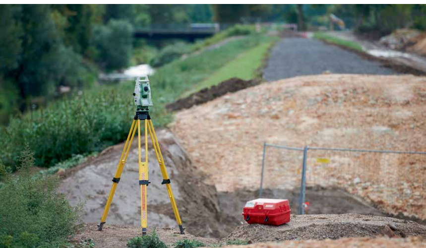
Vermessung des bestehenden Hochwasserdamms an der Pfrimm bei Worms.
