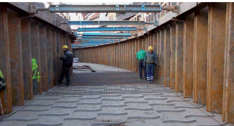
Sieht aus wie die Einfahrt zu einem Tunnel, zeigt aber in Wirklichkeit die Sanierung eines Kanals. Nach Beendigung der Arbeiten hat Michel Bau die Oberfläche wieder hergestellt, sodass der Welzbach weiterhin unterirdisch verläuft.
