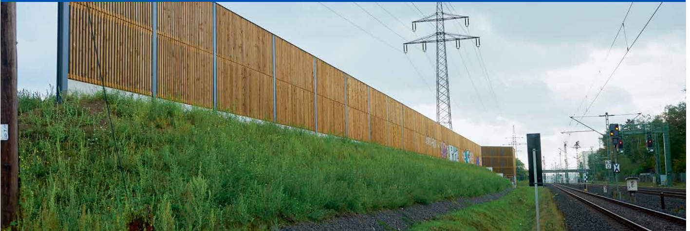
Schutz vor Lärmbeeinträchtigung durch die Bahn. Auf dem 3 m hohen Erdwall steht eine 4 m hohe Lärmschutzwand.
