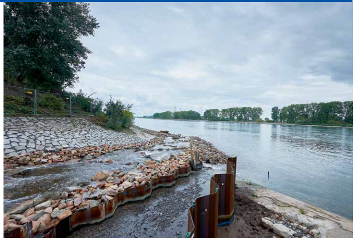
Die Hochwasserdammsituation inklusive Fischtrappe an der Mündung der Pfrimm in den Rhein.
