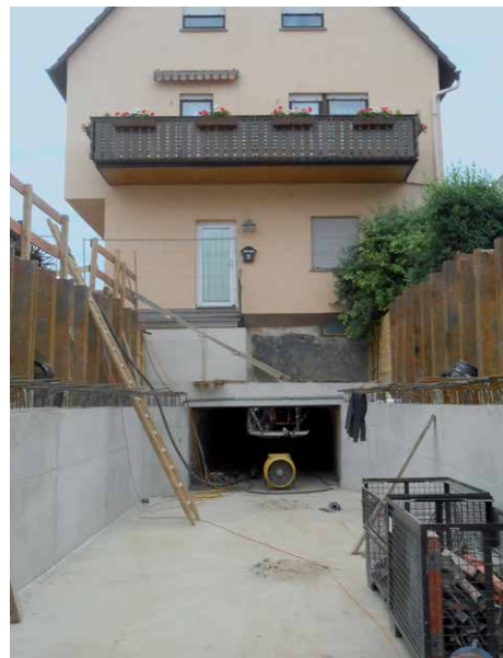
Da der Welzbach unter einem Wohngebäude fließt, musste auch hier saniert werden. Dabei wurde unter anderem mit Spritzbeton gearbeitet, um nachhaltig für Festigkeit zu garantieren.
