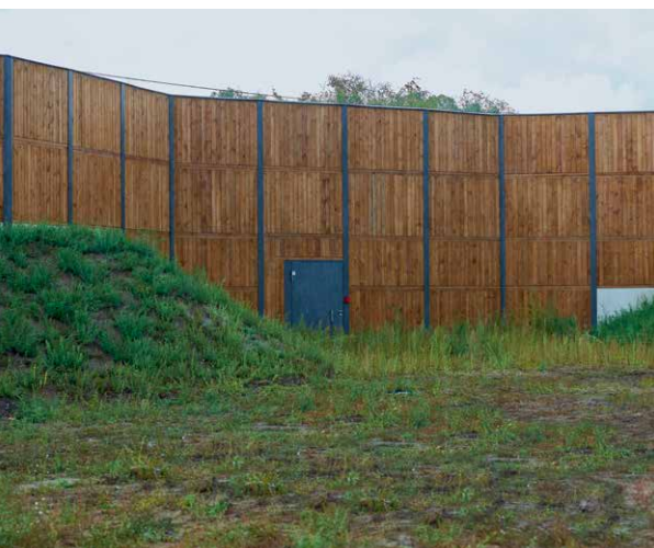
Michel Bau hat den Erdwall mit Lärmschutzwand zum Schutz der Bewohner des neuen Offenbacher Wohngebiets „An den Eichen“ gebaut.
