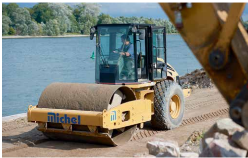
Nach dem Rückverfüllen der Kaianlage sorgt die Arbeit von Planiertrappen für eine dauerhafte Befestigung und Verdichtung der neuen Oberfläche.
