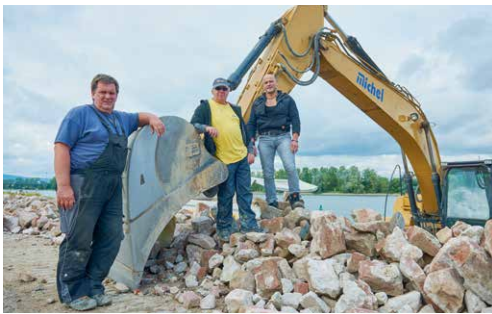
Stolz auf ihre Arbeit. Die Männer von Michel Bau geben Tag für Tag alles, damit das Projekt termingerecht abgeschlossen wird.
