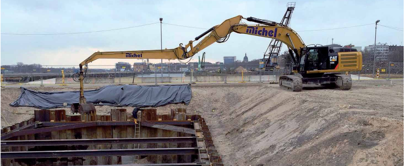
Bei den Sanierungsarbeiten auf dem Gelände des Zollhafens Mainz kam es sehr wohl auf die Länge – des Arms – an. Darum wurde der CAT 336E verlängert.
