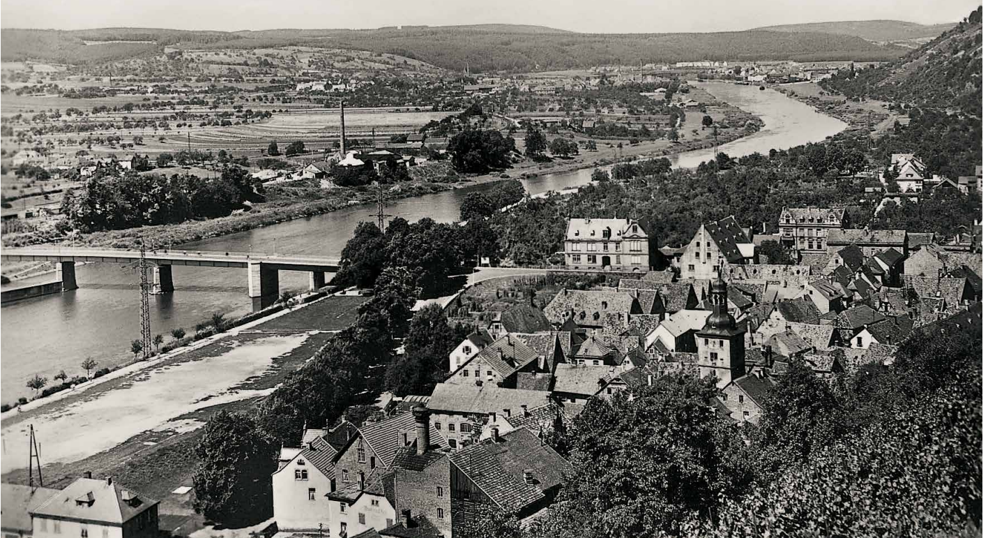
Gehört zur Michel Bau Geschichte: Die Klingenberger Mainbrücke stellt nicht nur für die Stadt ein bedeutendes Bauwerk dar, auch für das Familienunternehmen Michel Bau ist die 1880 erstmals errichtete und 1947 wieder neu aufgebaute Mainbrücke ein wichtiger Meilenstein in der Unternehmensgeschichte.
