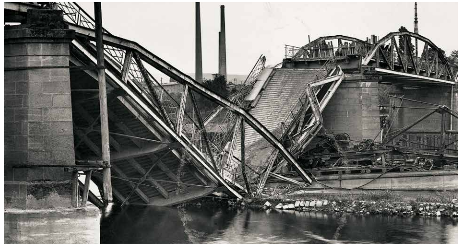
Brücken in Schutt und Asche. Im Zweiten Weltkrieg wurde die Mainbrücke von Klingenberg schwer beschädigt. Von 1947–49 wird diese eminent wichtige Verkehrsverbindung von Michel Bau komplett wiederaufgebaut.
