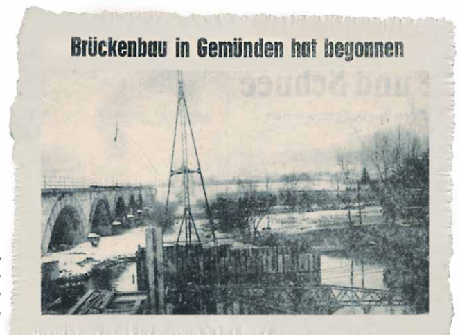
Auch die vom Krieg zerstörte Brücke im unterfränkischen Gemünden wird von Michel Bau in den frühen 1950er-Jahren wiederaufgebaut.
