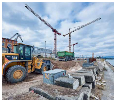
Michel Bau bei den Sanierungsarbeiten auf dem Baufeld des Zollhafens Mainz.
