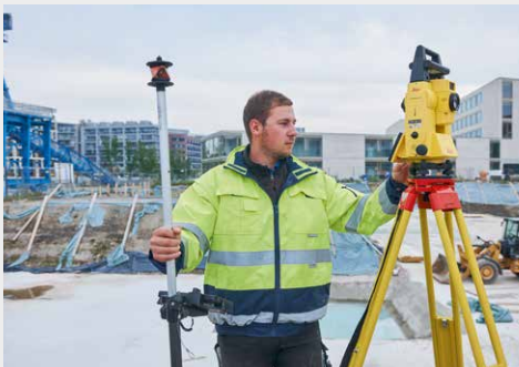
Das Tachymeter wird auf der Baustelle eingestellt, hier beim Projekt Marina Gardens in Offenbach.
