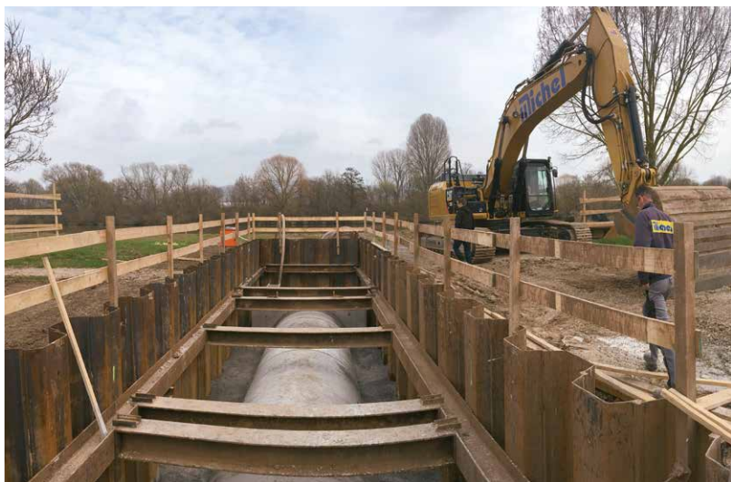
Der 12 m lange Rohrdurchlass verbindet die Fischkinderstube mit dem Neckar.
