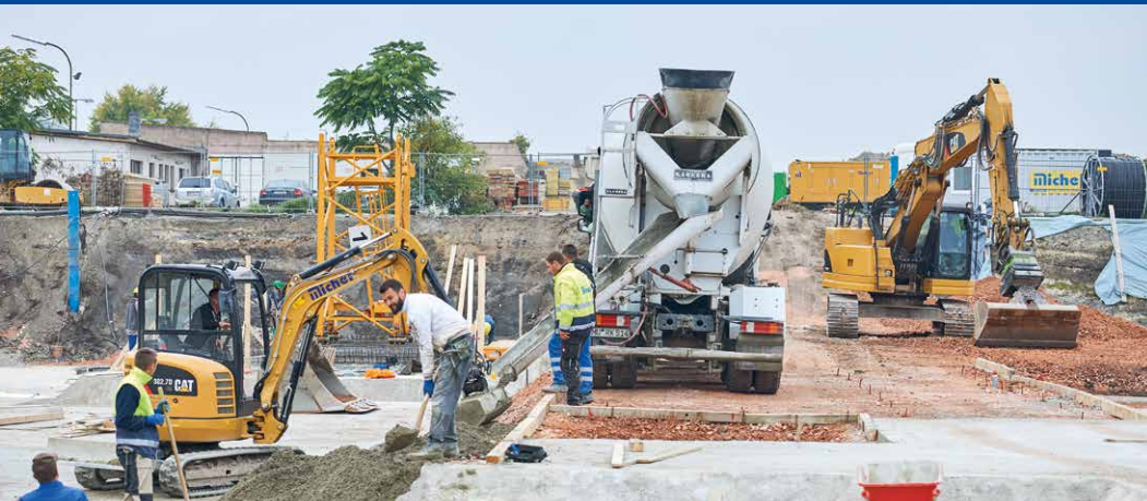
Die rund 6.000 m 2 große Baugrube der Marina Gardens Offenbach wurde von Michel Bau erstellt und für die weiteren Baumaßnahmen vorbereitet.
