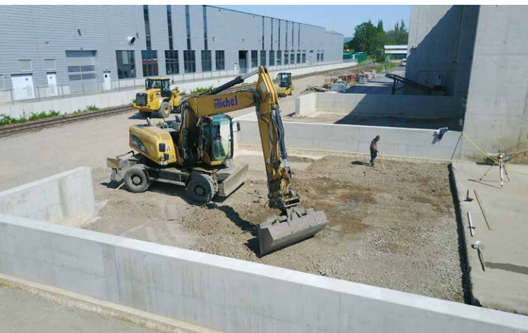
In Aschaffenburg entstehen drei neue Hallen zur Klärschlamm-trocknung.
