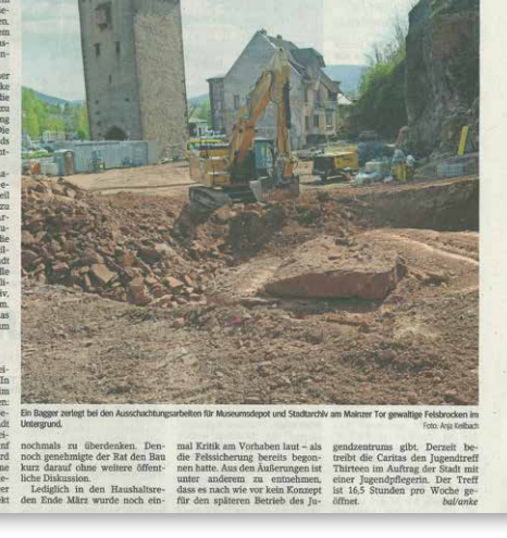
Ein Bagger zerlegt bei den Ausschichtungsarbeiten für Museumsdepot und Stadthof am Mainzer Tor gewaltige Felsblöcke im Untergrund. Foto: Anja Kellach
