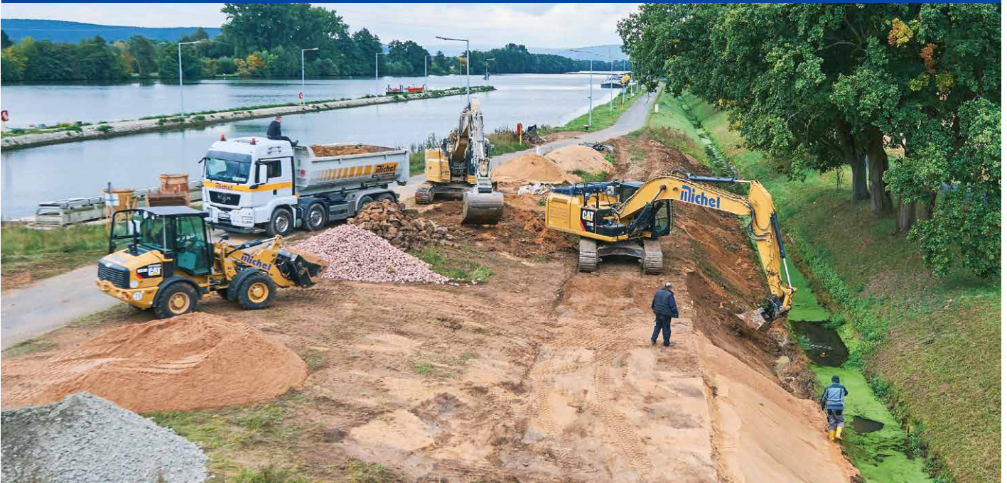
Auf einer Länge von 4,8 km – also 2,4 km je Mainseite – hat Michel Bau die Dämme im wahrsten Sinne des Wortes bearbeitet.
