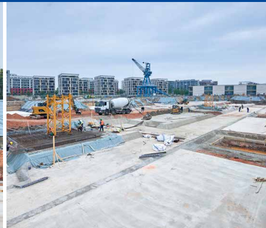
Selbstverständlich hat Michel Bau auch sämtliche Betonierarbeiten ausgeführt.
