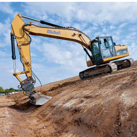
Ein leistungsstarker Bagger von Michel Bau beim Einsatz auf der Deponie Ellerstadt.
