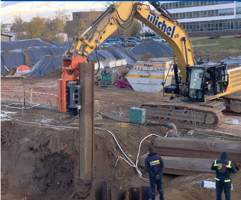
Erstmals kam die eigene SG 75V – eine Seitengriffpahramme des finnischen Herstellers MOVAX – als V-Rüttler mit entsprechender Steuerungstechnik in der Friesstraße zum Einsatz. Grund: Auf der direkt neben einem Rechenzentrum liegenden Baustelle war erschütterungsarmes Arbeiten gefordert. Lösung: Diese Hochfrequenz-Vibrationsramme mit 75 t Zentrifugalkraft reduziert dank eines verstellbaren variablen Exzentermoments das Übertragen von Schwingungen auf Nachbargebäude.
