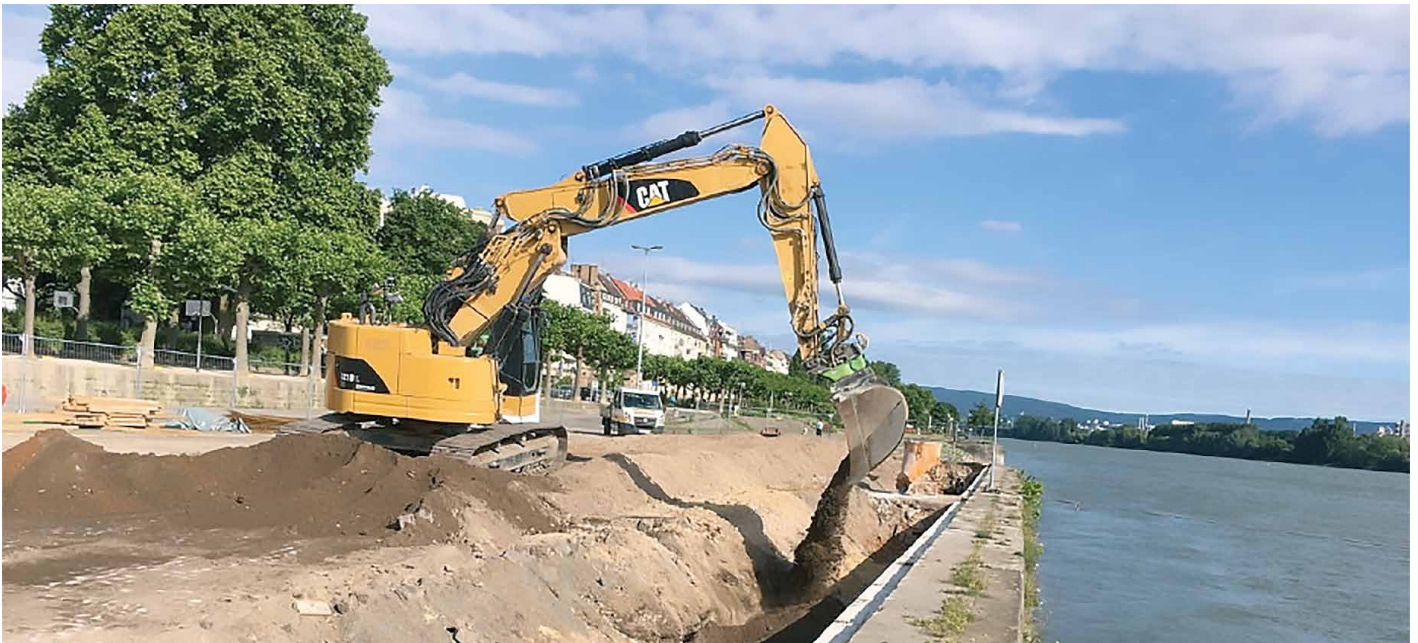
Bevor mit den eigentlichen Sanierungsarbeiten der Kaimauer bei Rhein-km 499 in Mainz begonnen werden kann, muss Boden ausgehoben und entfernt werden.
