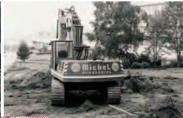
Das Pflegeheim in Erlenbach wird gebaut. Mit im Einsatz ist der moderne Hydraulikbagger RH 12 von Orenstein & Koppel (O&K).
