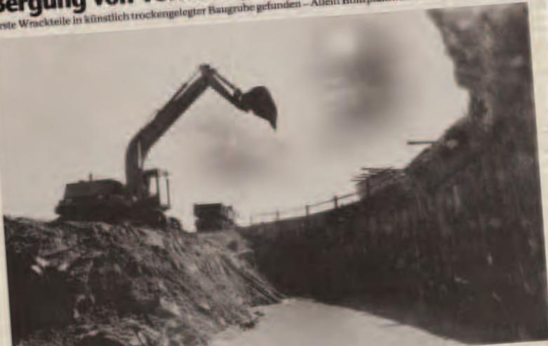
1,7 Meter in die Tiefe ragen die 135 Pfähle dieser „überschweren Bohrfahrwand“. Sie haben die Absturzstelle des Tornado jet bei Wassertrüdingern so stabilisiert, daß das Ausbaggern ohne große Schwierigkeiten vorantreiben gehen kann. Jeden Tag heißt das Bergungsteam, den Buntmetall „an den Haken“ zu bekommen. Allein das Betonieren der Wand koste zwei Millionen Mark.
