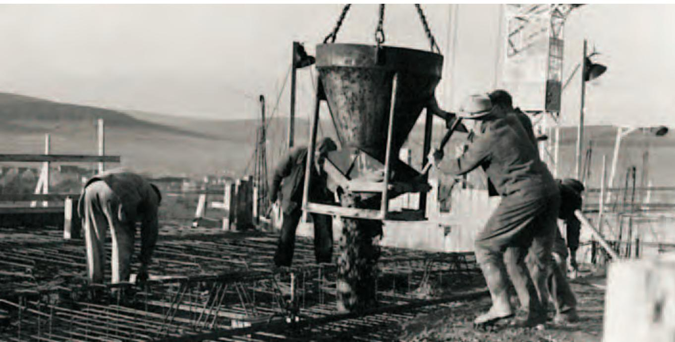
Auf der Großbaustelle Autobahnabfahrt Würzburg-West sind Bauarbeiter beim Betonieren der Fahrbahnoberfläche.
