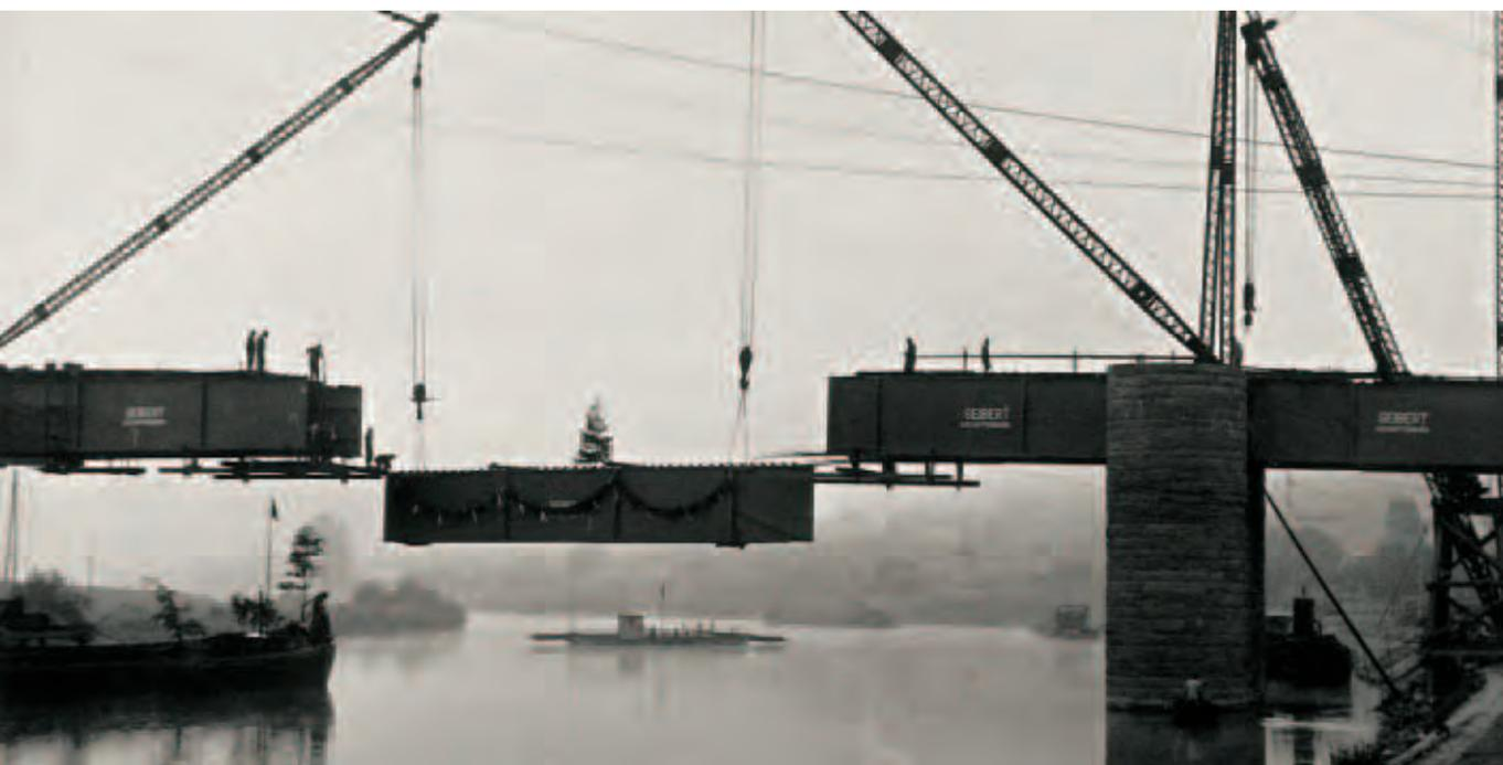
Beim Richtfest der Freudenberger Mainbrücke zu Beginn der 50er-Jahre wird das Mittelstück – auf dem der Richtbaum gut zu erkennen ist – von gewaltig dimensionierten Kranen eingesetzt. Am Bau dieser Brücke ist Michel Bau maßgeblich beteiligt.
