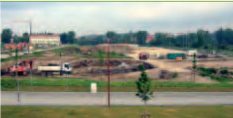
In Rositz, Thüringen, wird die Sanierung eines ehemaligen Teerverarbeitungswerks durchgeführt. 250.000 cm<sup>3</sup> stark belastete Erde und Baustoffe werden entsorgt.
