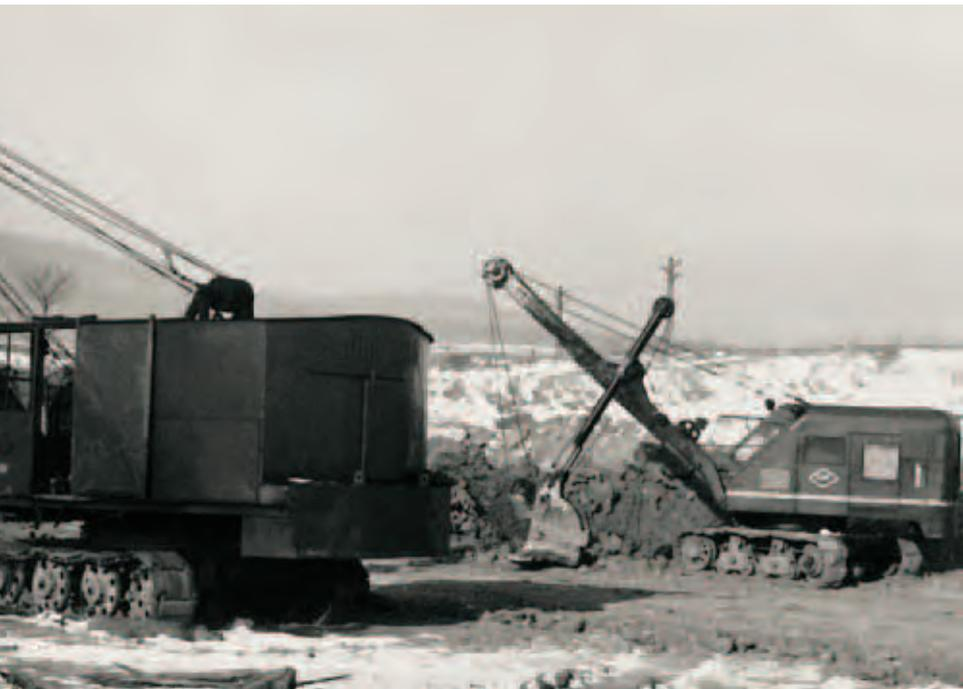
Zwei legendäre Maschinen beim Einsatz auf der Baustelle Gemünden. Rechts der Hochlöffelbagger L 301 von O&K, links ein Bünner-Bagger.
