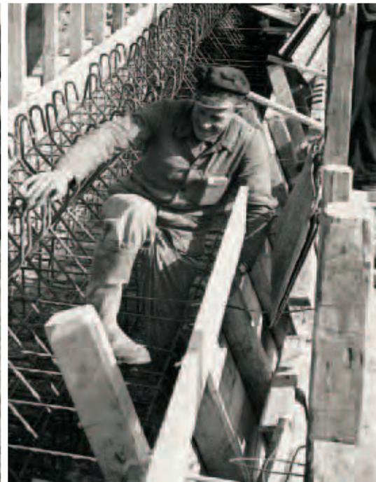
Auf der Klingenberger Mainbrücke wird das Armierungsgewebe für die Betonierung vorbereitet.
