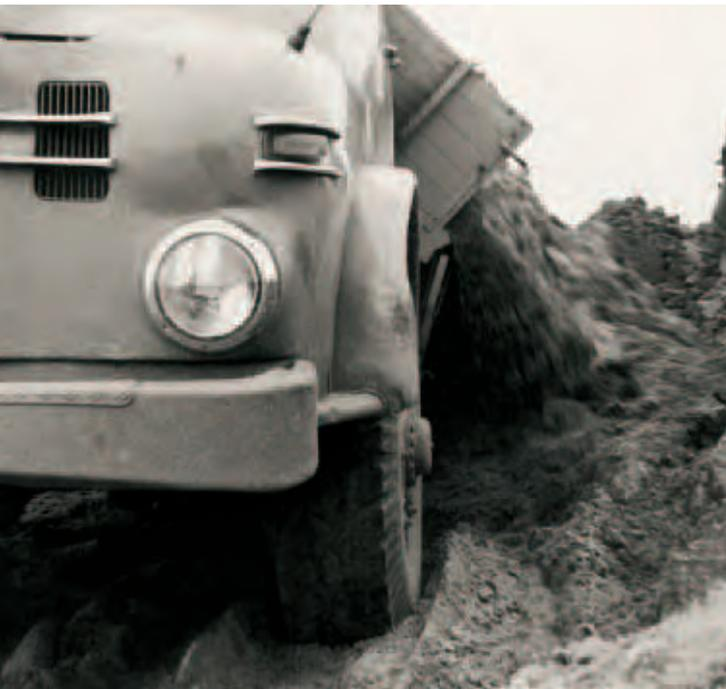
Mit einem MAN-Lastwagen wird das Material zur Dammaufschüttung aus der Vorderpfalz nach Ludwigshafen transportiert.
