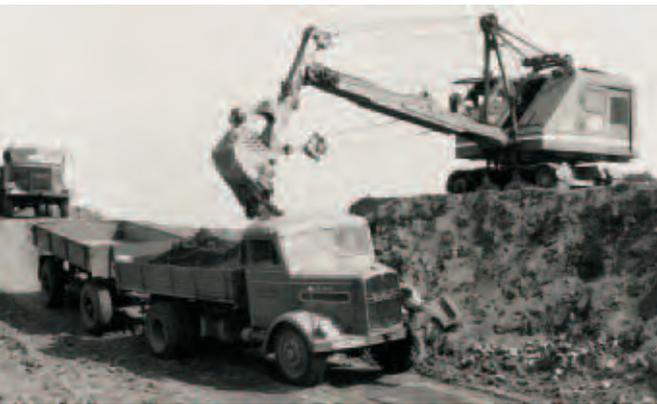
Der ca. 70 PS starke Seilzugbagger O&K L201 mit Tieföffel beim Beladen eines LKWs auf der Großbaustelle in Ludwigshafen. Mit den O&K-Baggern wird eine gute Wahl getroffen, denn sie erweisen sich mit ihrer unverwüstlichen Technik selbst im härtesten Baustellenbetrieb als absolut zuverlässige Geräte.
