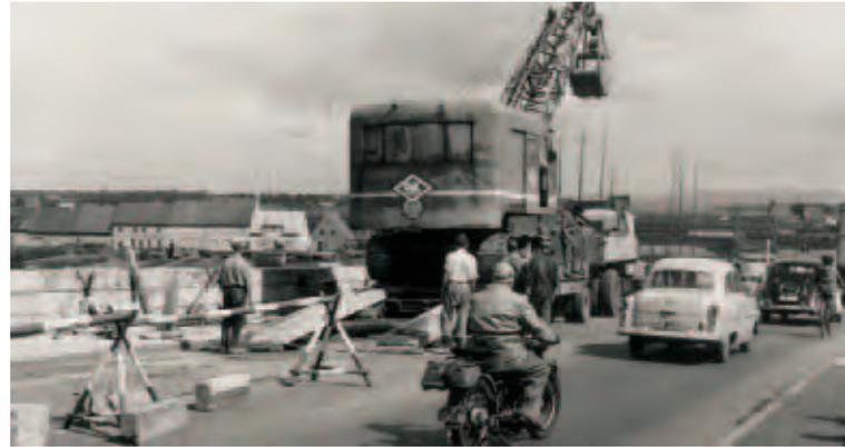
Der O&K L 301, ein richtiges Ungetüm von einem Bagger, im Jahre 1952 bei den letzten Arbeiten an der Mainbrücke in Kitzingen, auf der schon einige Auto-, Moped- und Fahrradfahrer unterwegs sind.
