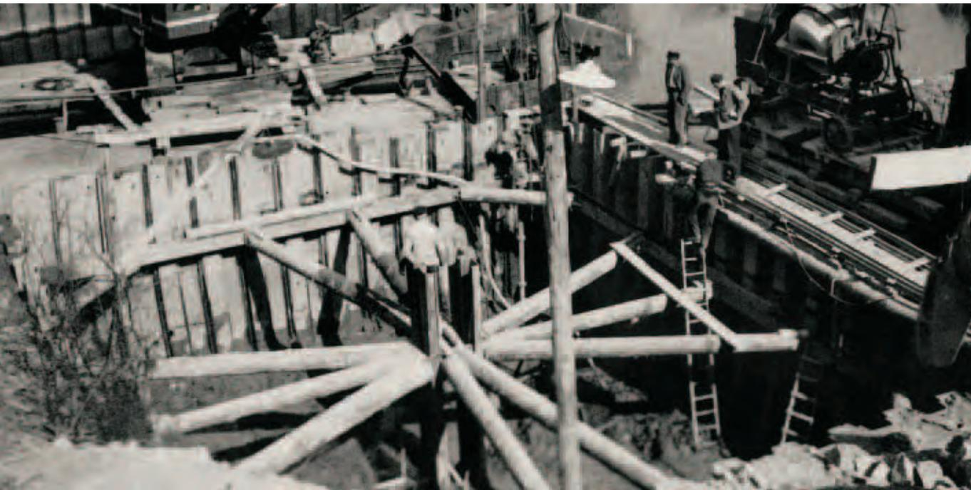
Eine heikle Aufgabe beim Bau der Brücke in Gemünden: Die Bauarbeiter sind mit dem Abspunden des Mittelpfeilers beschäftigt.
