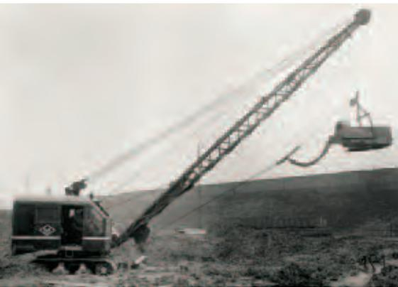
Ein Schleppschaufelbagger O&K L301 mit 28 t Gewicht und ca. 70 PS Leistung, der ab 1951 gebaut und bei Michel Bau eingesetzt wird.
